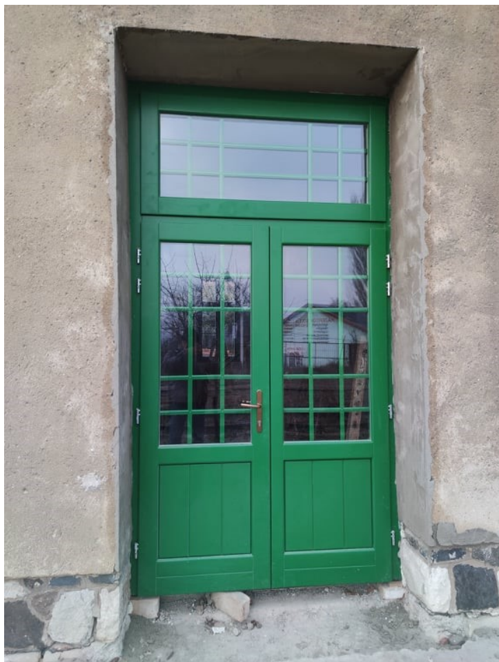
Beépítésre került az új bejáratí ajtó
