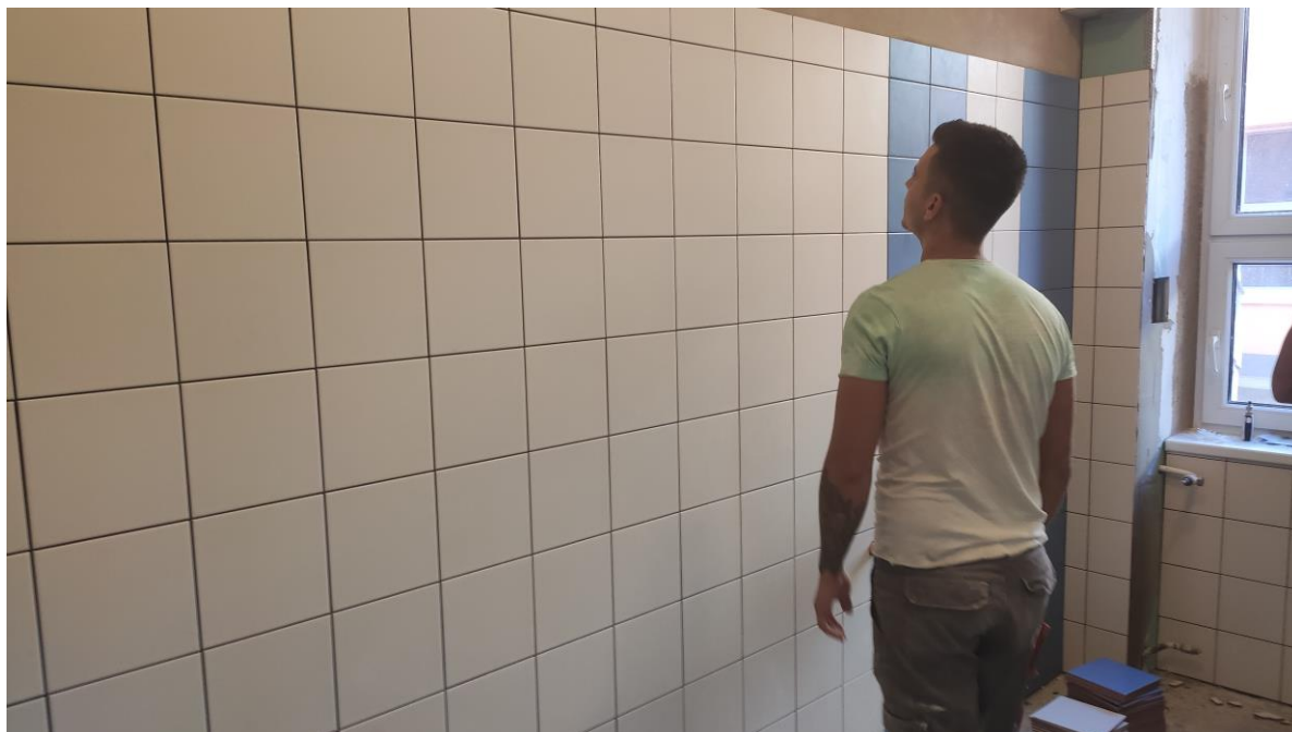
A vizesblokk felújítás közben
