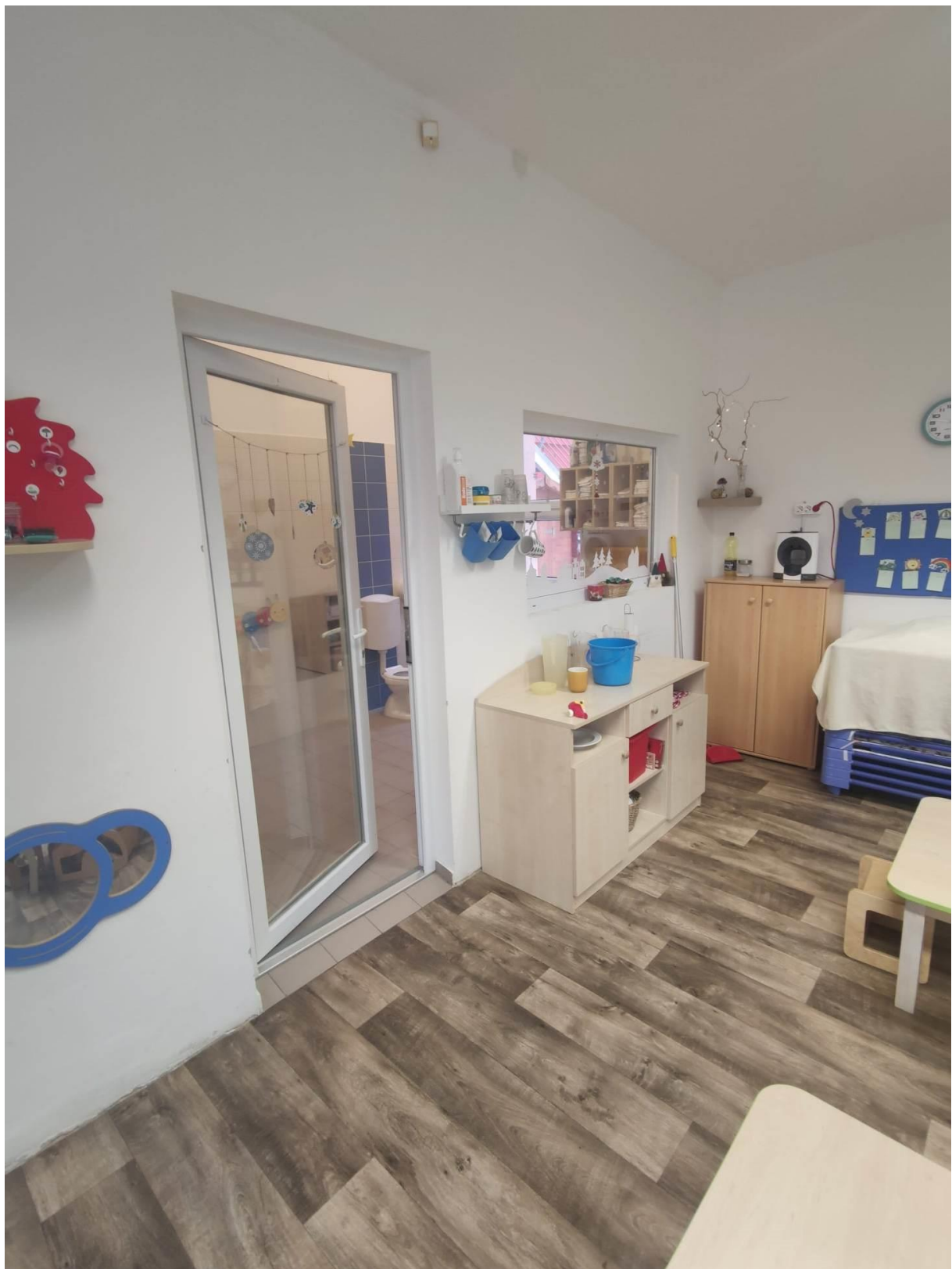
A csoportszoba is teljeskörűen felújításra és berendezésre került
