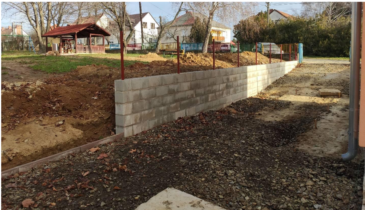
Támfal építés a Gesztenyés utcai óvodában
