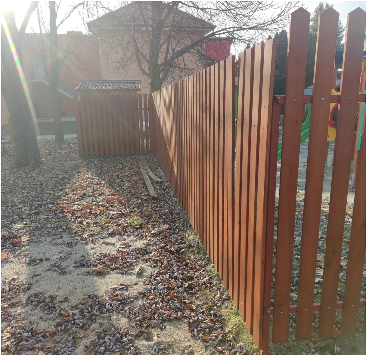
Belső fakerítés a bölcsődei udvarhoz
